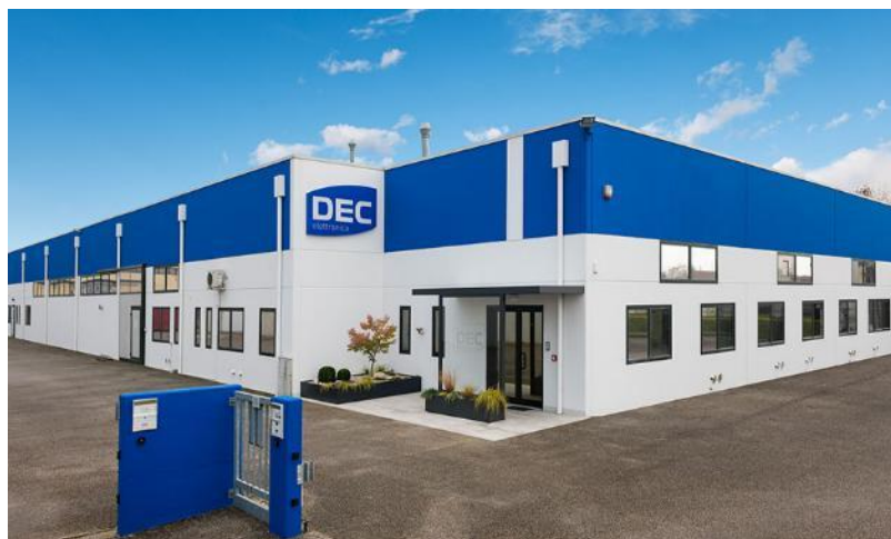
Stabilimento produttivo in Via dell'Artigianato, 12/131040 - Fossalta Maggiore di Chiarano (TV) - Italy
